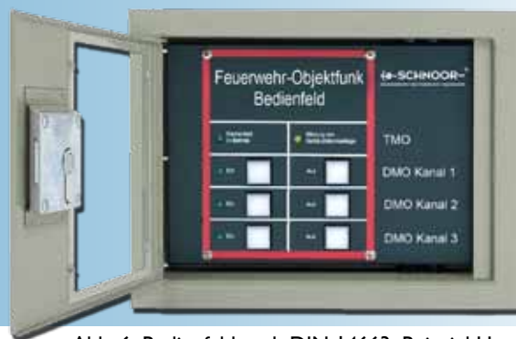
Abb. 6: Bedienfeld nach DIN 14663, Beispiel Hamburg
