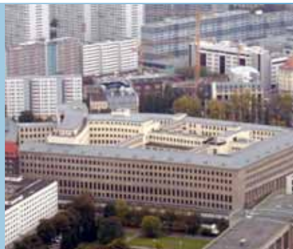
Abb. 2: Objektversorgung wird benötigt
